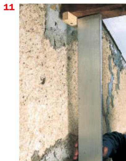
**11. Si les poutres sont apparentes, visser un morceau de tasseau directement sous la poutre, lui aussi aligné avec les autres tasseaux de l'ossature.**
